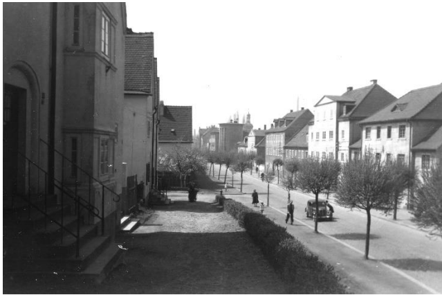
Historische Aufnahme Tessenow-Siedlung Pößneck
