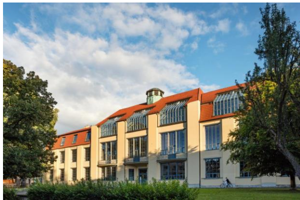
Hauptgebäude der Bauhaus-Universität Weimar
